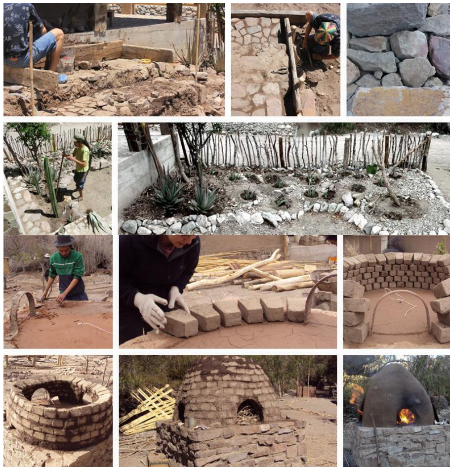
Fig. 3. Faenas de construcción de jardines y otros equipamientos. Fuente: Colectivo Pintepaisaje.
