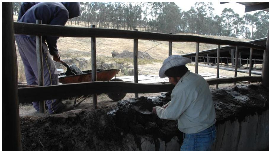
*Fig. 5. Levantamiento de muros de contención, por parte del personal de mantenimiento del Parque.*
