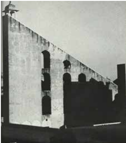
Figura 1. La escalera del gran reloj de sol
