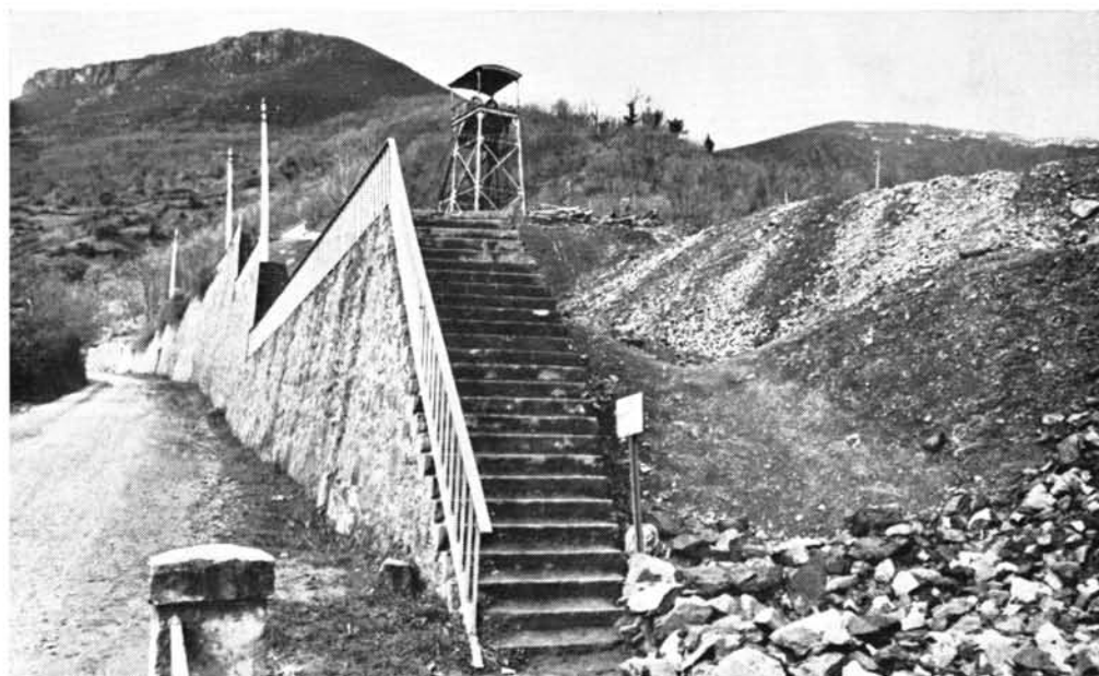
Vista del pozo minero denominado «S. Jerónimo», perteneciente a Hullasa. Está situado en la zona denominada La Aragona , en la confluencia de dos riachuelos.
