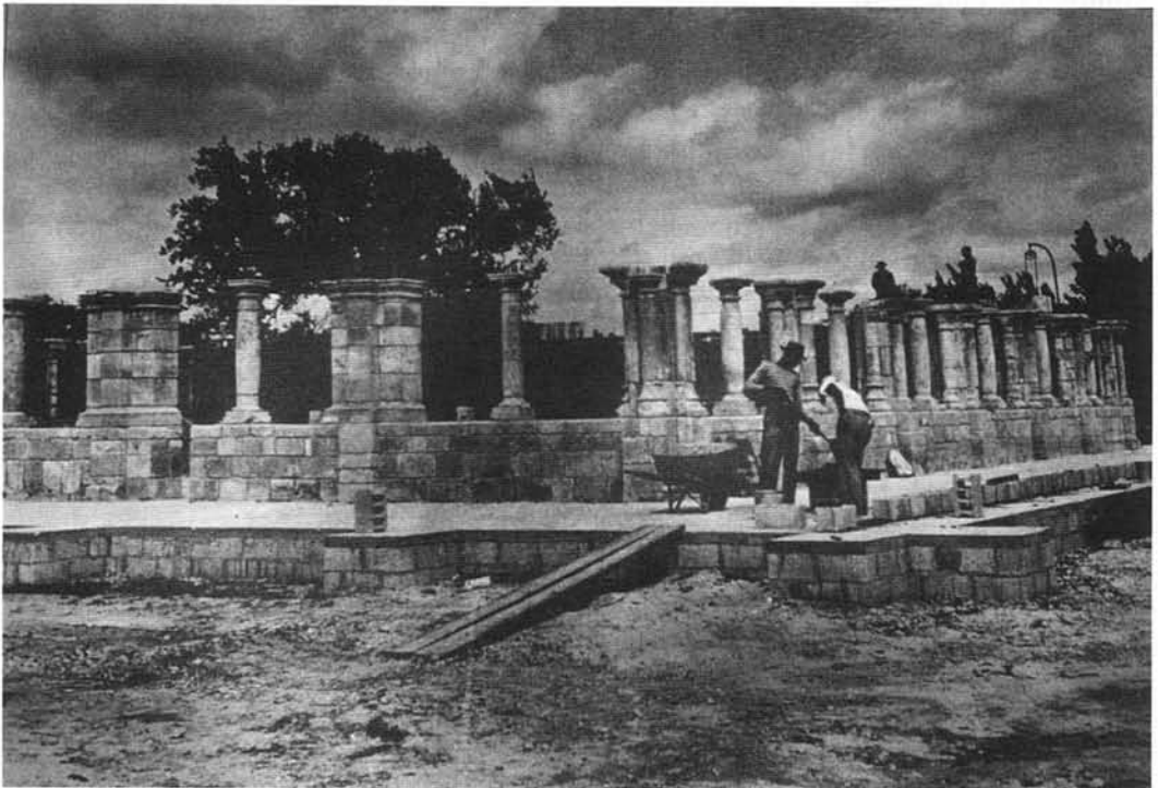
Fase de reconstrucción del monasterio de Sacramenia en el norte de Miami
