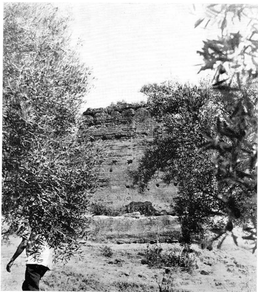
VISTA DEL TORREON SUROESTE DE LA FORTALEZA. PUEDEN OBSERVARSE LOS AGUJEROS ADONDE SE COLOCABAN LOS TRAVESAÑOS PARA HACER EL TAPIAL DE ARGAMASA. (FOTO DEL AUTOR)
